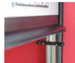
Protection optique de la lèvre d'étanchéité de la porte. Installation avec les portes à seuil bas.
