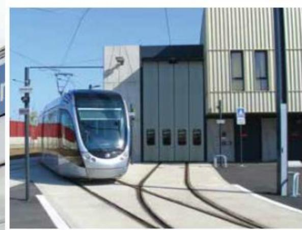
Portes fabriquées sur mesure pour le secteur ferroviaire, avec découpes spécifique pour le passage des caténaires.
